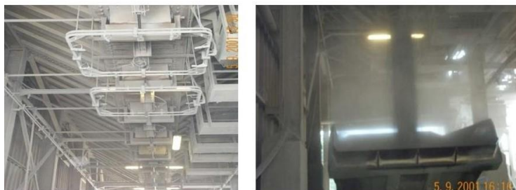
Abattage de poussières lors du déstockage sous trémies par la projection d'eau finement pulvérisée qui crée un brouillard sous les trémies
